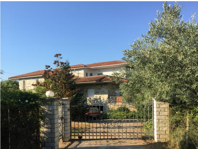
ΦΩΤΟΓΡΑΦΙΑ 5. Χ.Θ 1+150 : Διώροφη νεότερη κατοικία
