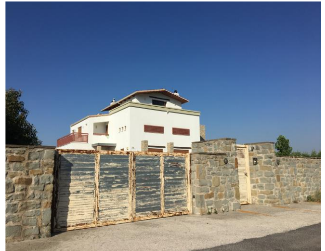
ΦΩΤΟΓΡΑΦΙΑ 6. Χ.Θ 1+850 : Διώροφη νεότερη κατοικία
