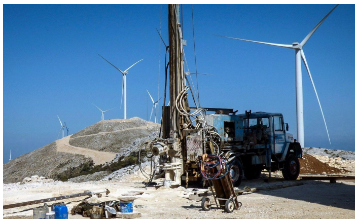
Αιολικός σταθμός στα Ακαρνανικά Όρη.
